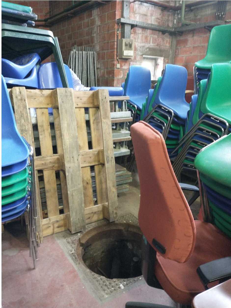
Foto 3: putdeksel ondergrondse tank
