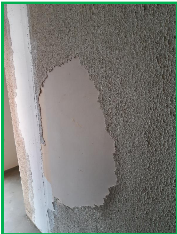
Figuur 3: Muren in de gang op alle verdiepingen: gipsplaten: geen asbest.
