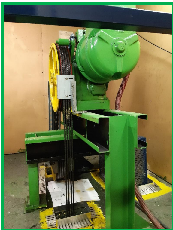
Figuur 4: liftmachinekamer: geen asbest.
